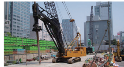
場所打ち杭(アースドリル工法)の現場
