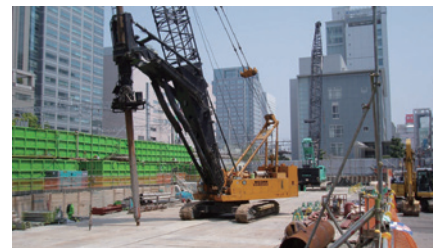
場所打ち杭(アースドリル工法)の現場
