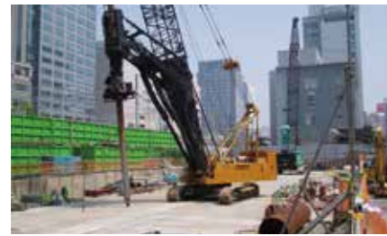
場所打ち杭(アースドリル工法)の現場
