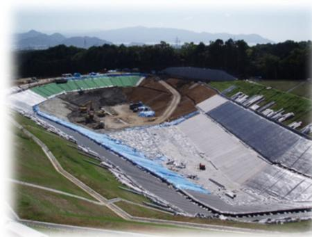
ベントナイト混合土が用いられているほか、「クニシール」や「クニシート」の止水材が、主に地下構造物の防水材料として使用されています。
